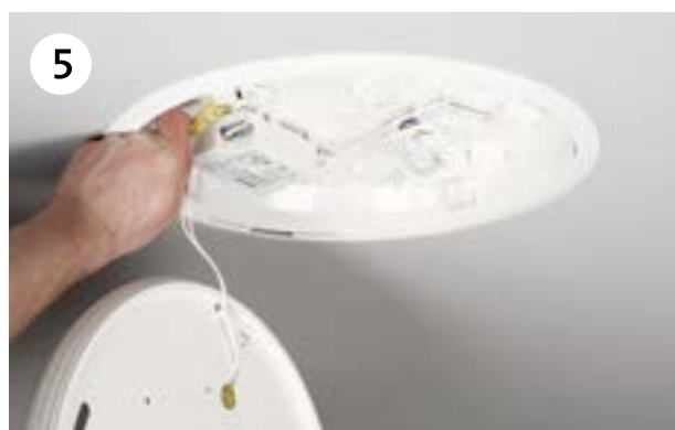
5 Fest sikkerhetslinen og koble til med hurtigkoblingen. Monter skjerm med LED-modul i armaturhuset med en bajonettlås.
