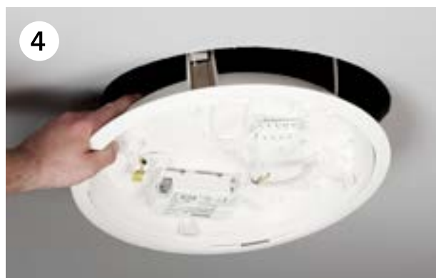
4 Trekk nettledningen inn i armaturen og frigjør de tre låsefærene. Armaturen installeres i hullet.
