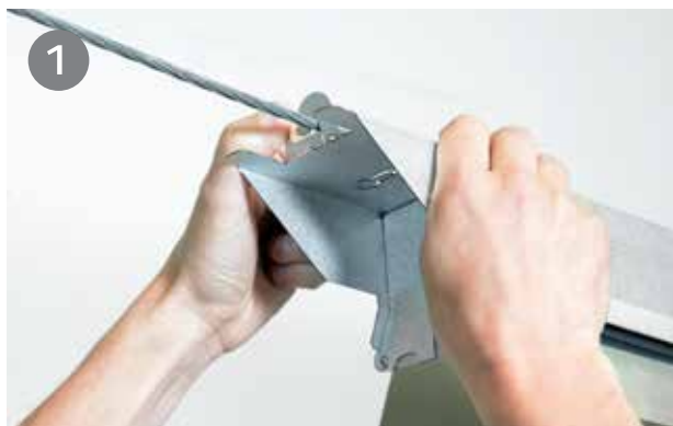
1) Armaturen monteres på linen og sikres med en integrert innfesting.
