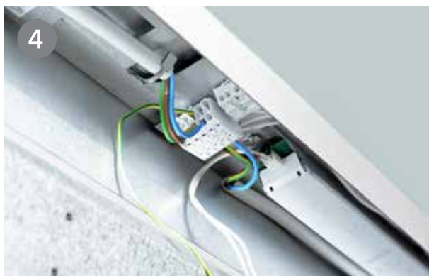
4) Ledningen kobles til en 5-polet gjennomgangskobling.
